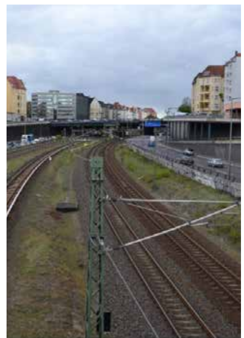
Hier soll der Deckel hin
