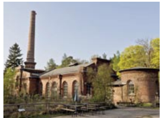
Ehemaliges Wasserwerk am Teufelssee
