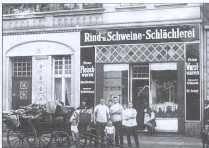
Haus Klausenerplatz Nr. 8 ca. 1920
