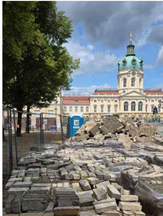
Zurzeit werden am Schloss Kanäle und Wege gebaut.
