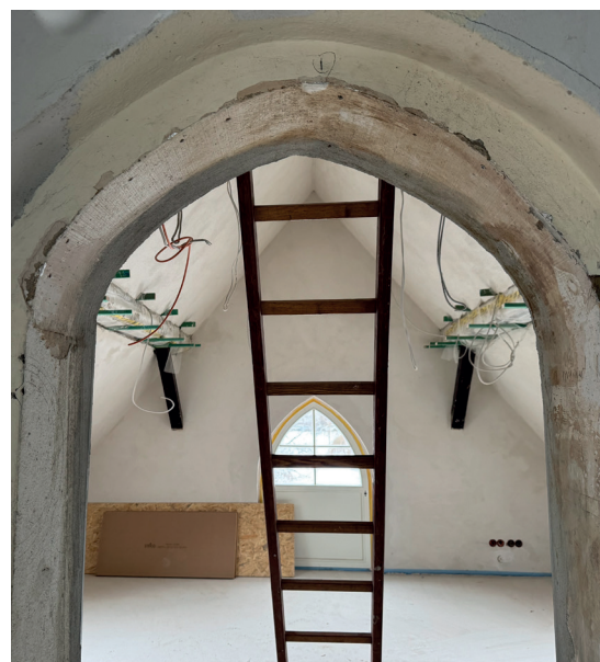
Dachgeschichten – innen wird noch gearbeitet.
